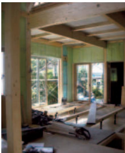
写真3 戸建て住宅の最近のこそ・床組み工法
