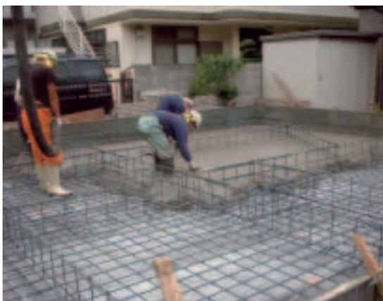
写真1 戸建て住宅の基礎コンクリートの打設工程
