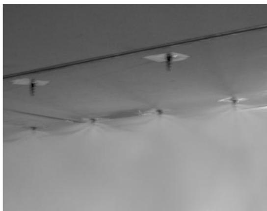
写真5 天井近傍のウォータースクリーンの状況
