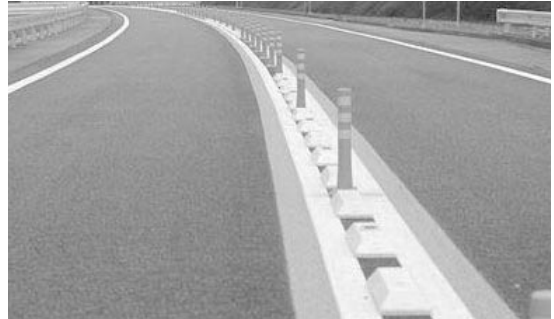
写真1 中央分離帯ブロック
