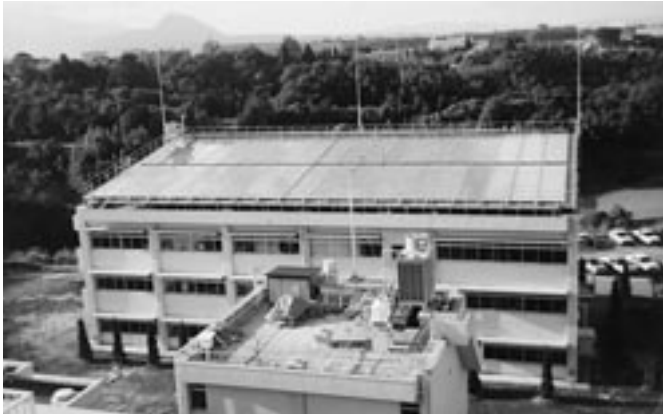
写真2 サンシャイン計画の大分大学エネルギー工学科校舎。屋上に平板集熱器と手前に機械室棟が見える。
