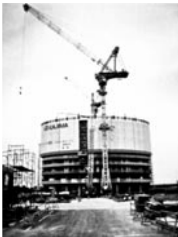
写真2 60N/mm 2 の高強度コンクリートを用いた、超高層RC集合住宅の施工状況
