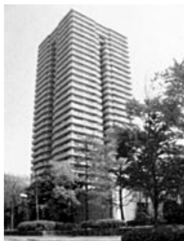
写真1 42N/mm 2 の高強度コンクリートを用いたRC超高層集合住宅（パークシティー新川崎35階建 1987年竣工）
