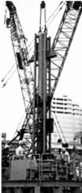
写真4 構真柱の建込み作業状況
