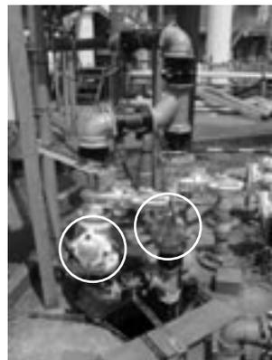
写真5 逆止め弁(左がボール式、右がスイング式)
