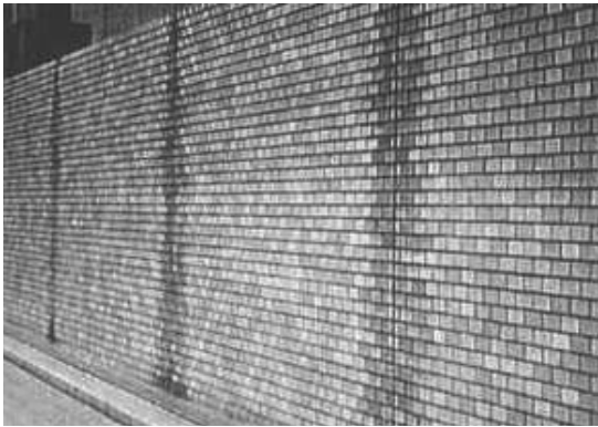
写真5 シリコン系シーリング材複合塵埃付着 (一般目地)
