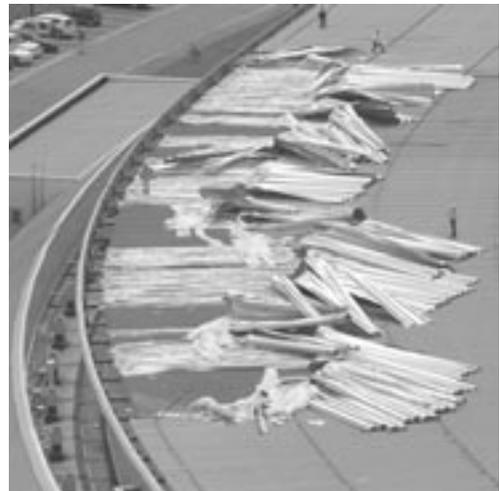
写真2 2004年台風18号による蓄積リング棟屋根東部分の被害(読売ニュース)
