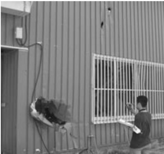
写真4 飛散物による壁面の破損
