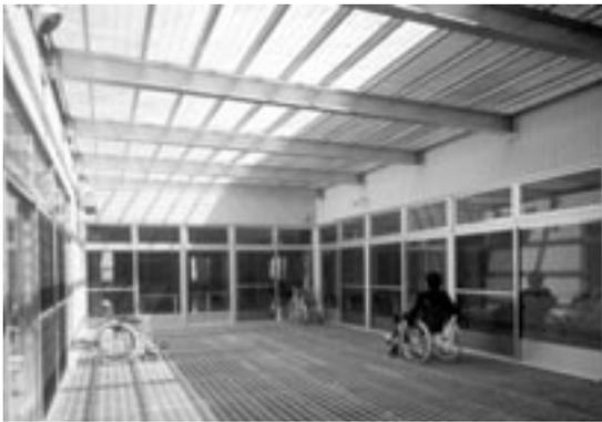
写真1 老健施設「風の杜」2階の防災バルコニー。上は3階の防災バルコニーだが、床がグレーチングのため、光が通って明るい(写真は早大・入江研究室提供)。
