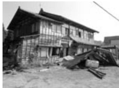
写真5 大きな被害を受けた伝統的な軸組構法
