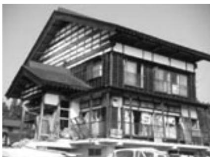
写真6 大きな被害を受けた1階RC造の高床式木造
