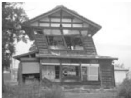
写真7 2階の残留変形が1階より大きい被害例
