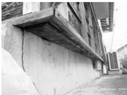
写真2 基礎から大きくずれた土台
