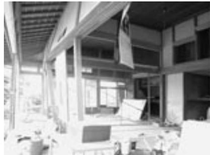
写真3 柱の折損等大きな被害を受けた農家型民家の例
