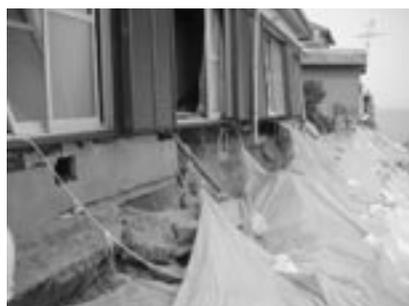
写真8 地盤被害による家屋の大破
