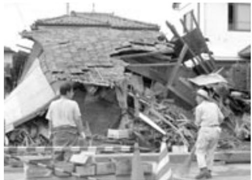
写真4 店舗併用構造の被害
