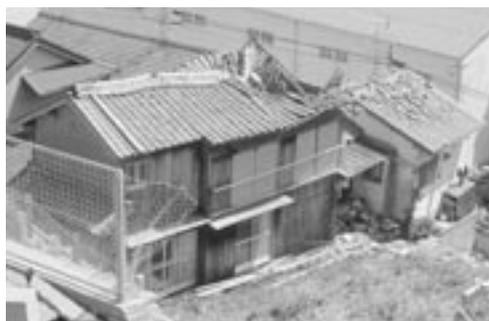
写真9 蟻害のために小屋が崩落した家屋
