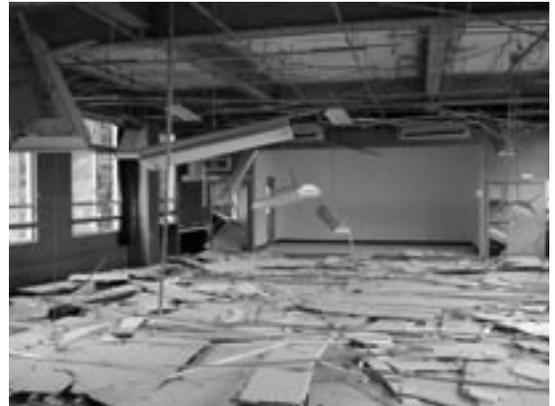
写真1 天井の落下による被害
