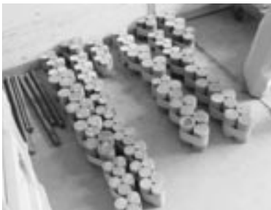
地盤改良材(搬入時)
