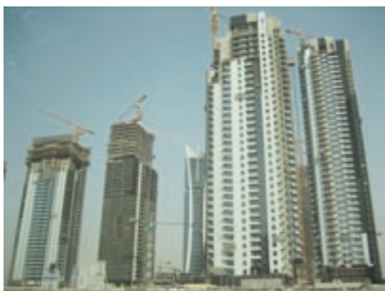
超高層部の外壁工事
