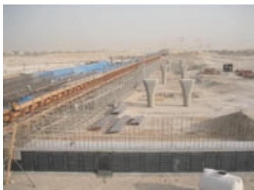
インターチェンジ工事
