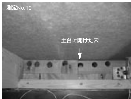
写真3 断熱材の欠損状況
