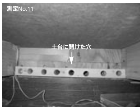
写真4 土台に穴を開けた状況
