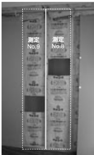
写真3 断熱材の欠損状況
