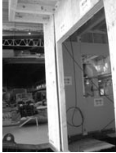
写真4 合板の浮き (標準試験体 Ver.2)
