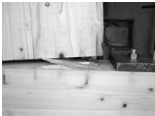
写真2 破壊状況 (M24ボルト M14タップ付きの抜け) 試験体記号：SH-1 最大荷重：11.4kN
