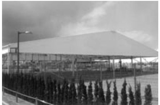
ポリエステル製膜屋根の施工例
