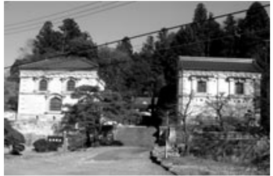
屏風岩石蔵 (大谷石組積造)
