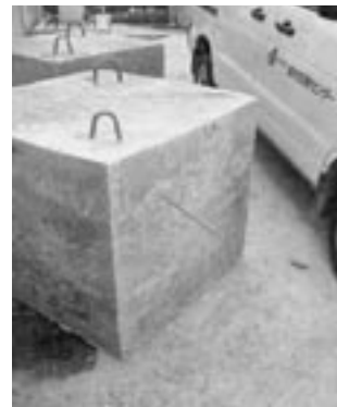
写真12 コンクリートの表面状況(合板I面)
