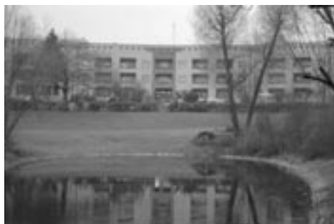
写真1 Britzの馬蹄形住宅：地上からは馬蹄形であることが分からない、しかし緑は豊富である。
