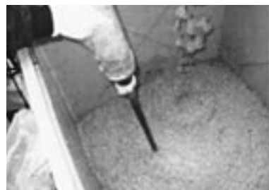
写真8 コンクリートの打設状況
