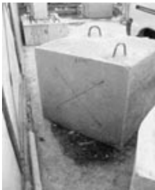
写真11 コンクリートの表面状況(廃木ボードI面)
