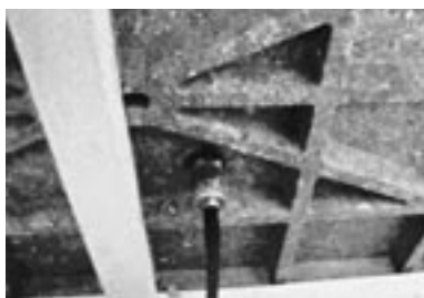
写真6 側圧計の設置状況(実験Ⅰ)
