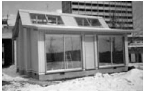
写真3 東北大学長谷川研究室のパッシブソーラーシステムの試験装置
