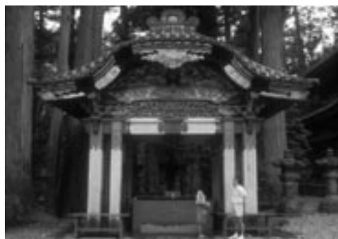
写真 日光東照宮の水盤舎 柱は御影石、頭貫、台輪、梁はけやき材に胡粉仕上げ
