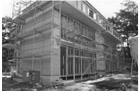
写真5 湿式外断熱工事が行われオンケルトムズヒュッテの建物
