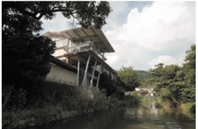
写真10 八幡浜市立日土小学校バルコニー
