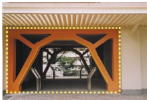
写真2 ブレース増設補強事例
