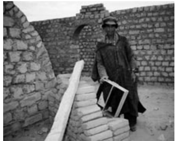
写真2 日干し煉瓦の型枠を持つ作業員
