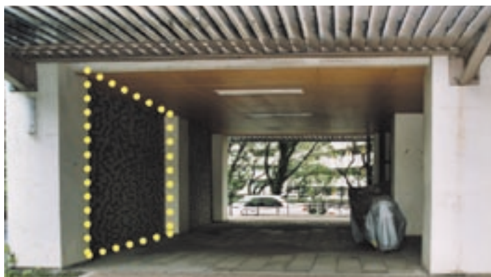
写真1 壁増設補強事例
