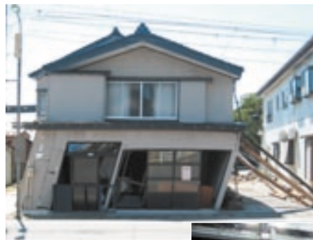
◀新潟県中越沖地震による木造住宅の被害
