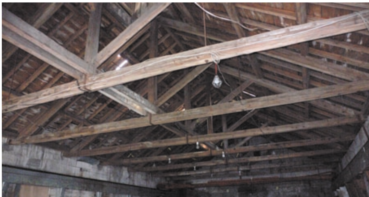
写真6 旧南豆製氷所内部
