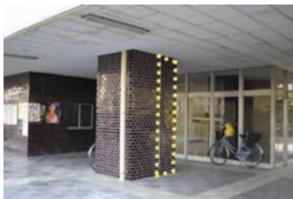
写真3 柱増打ち補強事例
