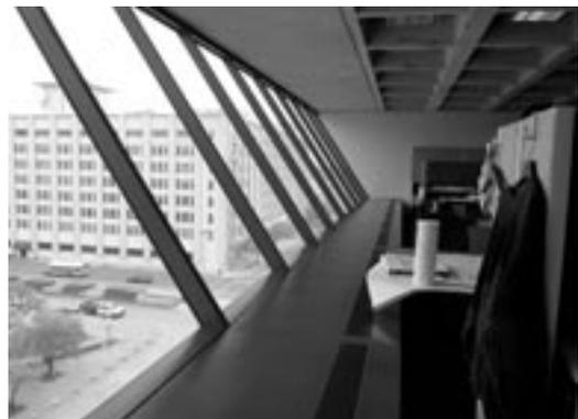
写真14 面外傾斜のガラス面、ただし嵌殺し・2
