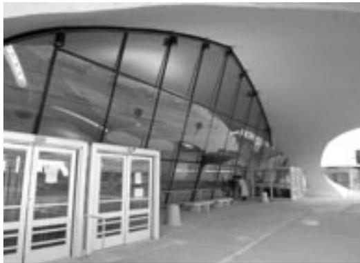
写真11 面外傾斜のガラス面で開口部は鉛直の例
