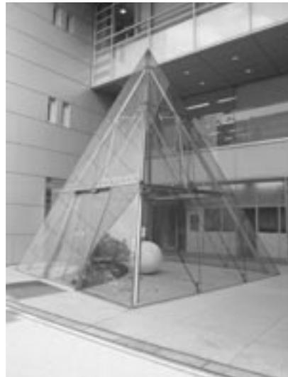
写真12 面外傾斜のガラス面で開口部も傾斜した例
