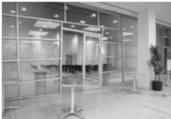
写真9 面内傾斜のガラス面で開口部を鉛直にした例
