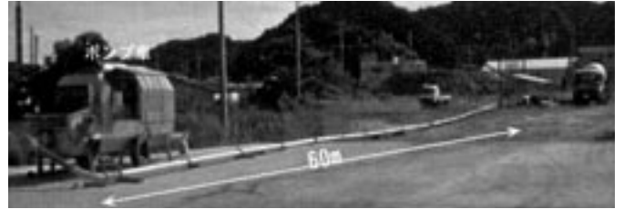
写真3 コンクリートポンプ圧送実験
