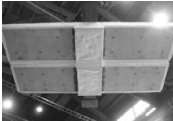
写真1 試験前の床下側（加熱側）の状況 (A50・A80)
