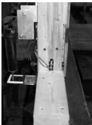
写真3 たて枠脚部の金物の設置状況
