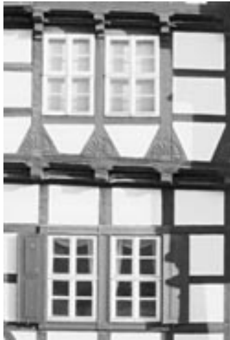
写真4 三角受木 (Konsoledreiecke) はドイツ木骨住宅の特徴である
