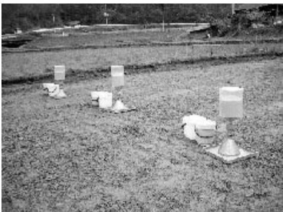
砂置換法による土の密度試験
