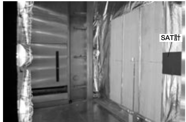
写真2 試験状況 (外気側)
