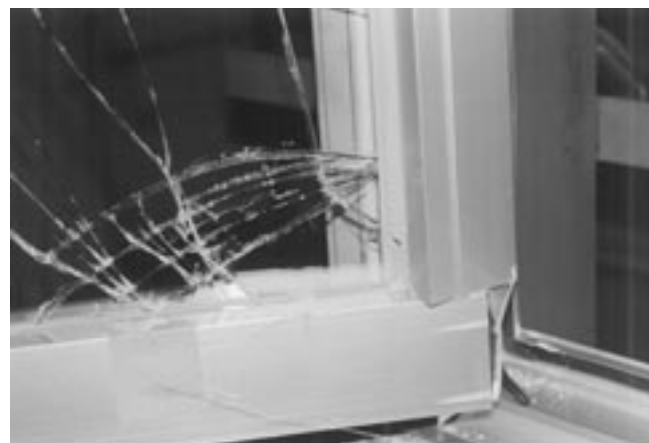
写真1 実験結果（自由落下、条件I、おもりの質量79.7kg）障子枠の変形が拡大し、ガラスが割れた状態
