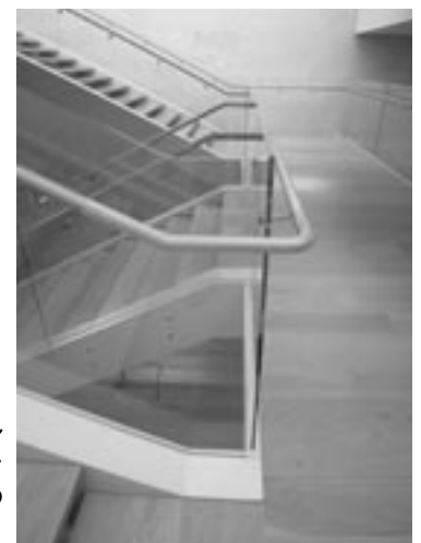
写真1 ナッシャー・スカ ルプチャー・センター(レン ツォ・ピアノ/ダラス)の 1段下げた階段と手摺
