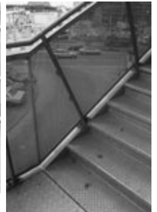
写真6 ベルリン・ポツダム広場再開発現場にあった赤い広報館「インフォボックス」の、0段目のある仮設階段
