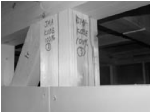
写真7 管柱の割れ
