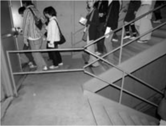
写真2 ダラス市庁舎 (I.M.ペイ/ダラス) の1段下げた折り返し階段
