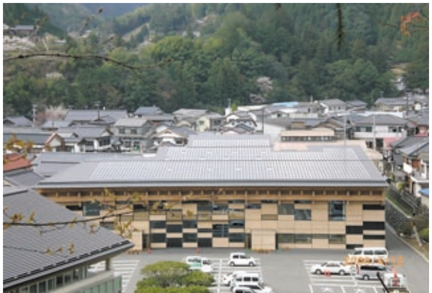
写真2 梶原町総合庁舎の屋根一体型太陽光発電パネル(80kW)
