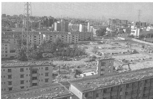
写真3 A街区南側建替工事
