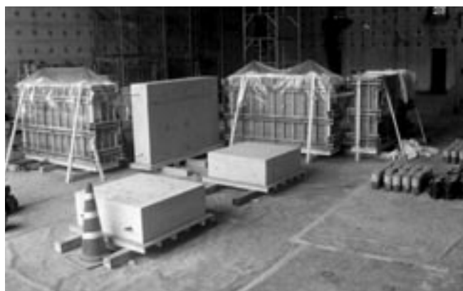
写真1 模擬部材の作製状況
