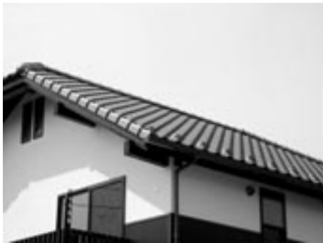
写真4 棟部・軒先がシンプルな屋根
