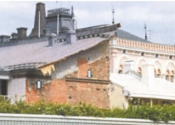
写真5 鉄骨を流して壁面を補強している例
