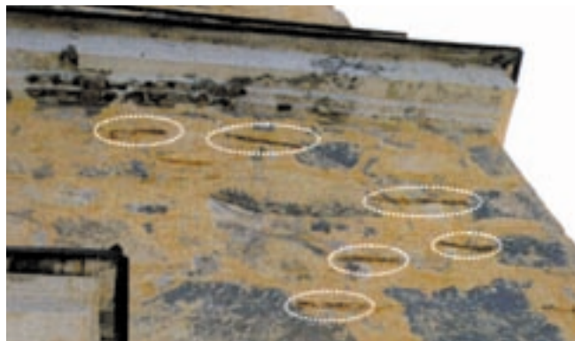
写真4 水平方向に設置された引き金物の例
