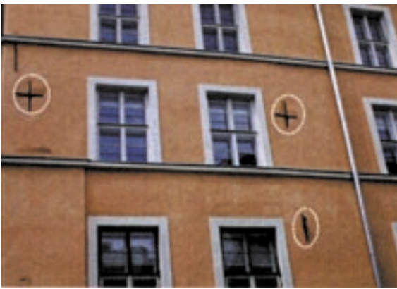
写真6 アパートの壁面の補強例
