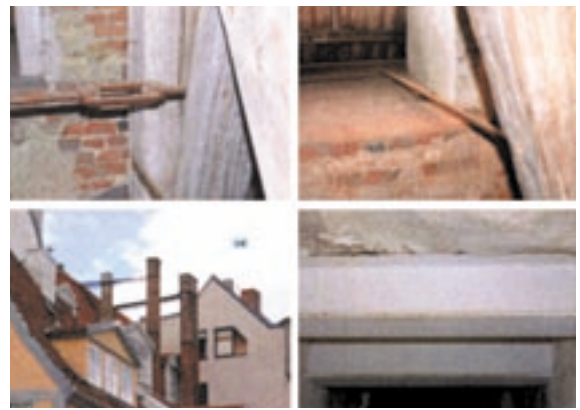
写真8 ターンバックル、鉄骨、ロープによる補強の例
