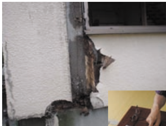
構造体の木質パネルが腐食している。「予想以上に内部で劣化が進んでいた」とBさん(写真:上はBさん、右は村島)
