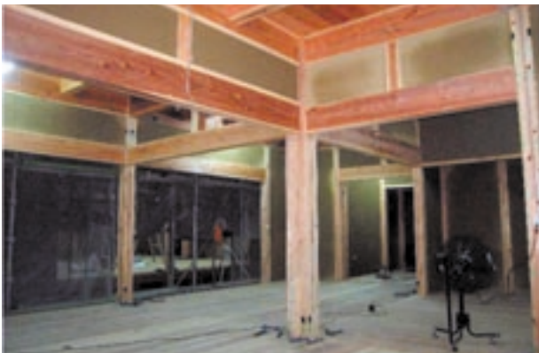
写真3 A棟1階内部
