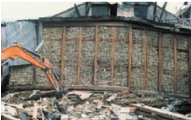
写真13 土壁の損傷
