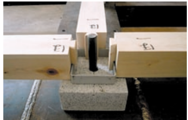
写真4 A棟柱脚の納まり
