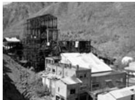
写真1 現在の足尾銅山製錬所
