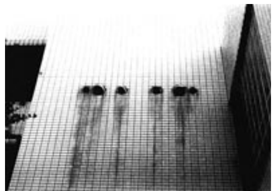
写真3 汚染物の付着に伴う汚れ（塵埃）
