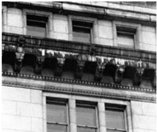
写真2 下地の影響による変化に伴う汚れ（エフロ）
