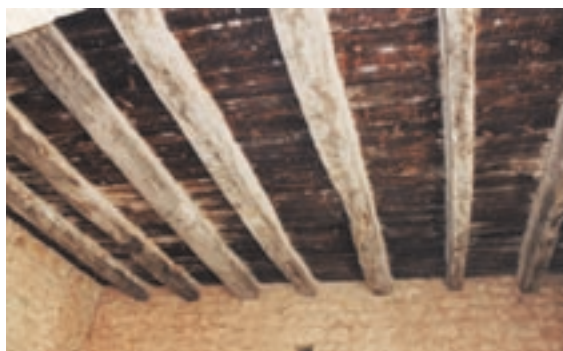
写真1 木の梁を並べた床 禁欲的で有名なシトー派の、ル・トロネ修道院(南仏)は、飾り気がいっさいない。
