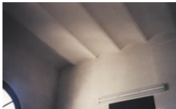
写真4 鉄骨梁と煉瓦アーチの床 バルセロナ郊外の岩山・モンセラに登るケーブルカーの駅。この構造の床はヨーロッパ各地でしばしば見られる。
