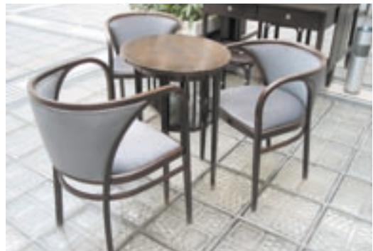
写真8 ガラスブロックの床 / 目地に鉄筋を入れることで、ガラスの曲げ強度に依存しない構造にすることが可能 (ウィーン貯金局, オットーワグナー設計)
