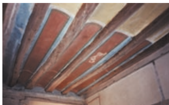
写真2 木の梁と煉瓦アーチによる床 バルセロナ旧市街の住宅で、壁は石造だが、木製の梁は挽む。
