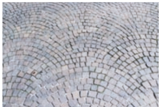
写真14 円弧が無限に連なる石畳／このタイプの石畳は我が国でも珍しくなかったが、新規の施工例はあまり見ないようである(リール、Palais des Beaux-Arts 周辺)。
