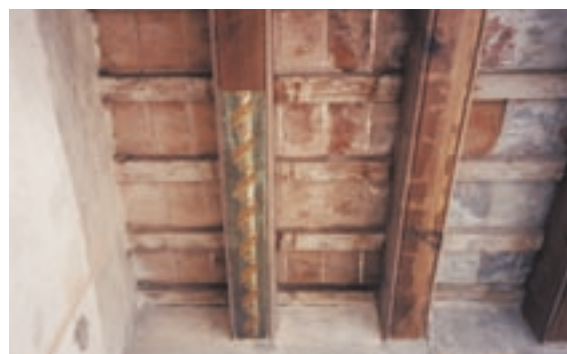
写真3 根太のある木製床 写真2と同じ建物の別の部分。かなり歴史のある地域なので、木造部分は後で改造されている可能性が大である。
