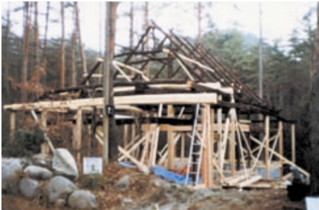
写真4 新築への古材組込み
