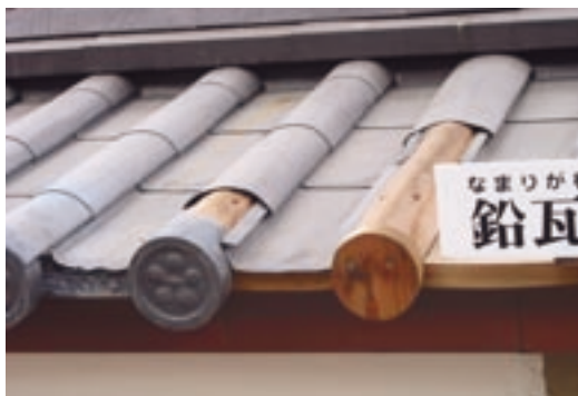
写真6 鉛板葺きの屋根 銃弾説の他に、耐久性説やコスト説も。厚さは案外薄く2mm程度。金沢城には他にも構法の説明がある。
