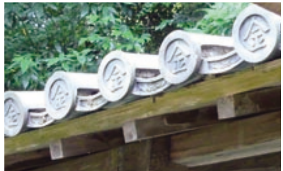
写真4 金毘羅マークの瓦 琴平山・表書院の丸瓦には⊗マーク。巴瓦の丸い部分には、三つ巴以外にも様々な模様が見られる。
