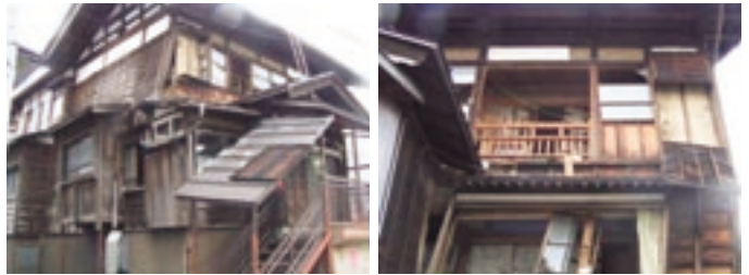
写真1 新潟県中越地震の被災家屋
