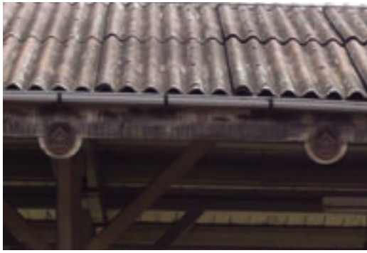
写真5 板金毘羅マークの軒飾り / JR琴平駅・ホーム上屋。ホーム上屋には古レール建築の典型が見られるが、木造トラスもなかなか興味深い(東京駅にもまだある)。
