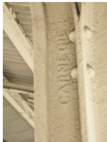
写真左 支柱の刻印 CARNEGIE
