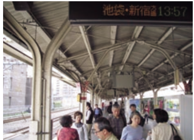
写真上 大塚駅ホームの古レールを使った支柱
