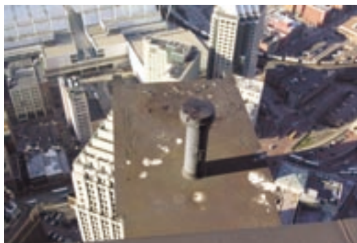
写真14 水を満たした耐火構造・2 / 外壁面から数メートル分の柱・梁は中空になっており、最上部には液体補充用のキャップがあって、実際に液体が入っていることがわかる。
