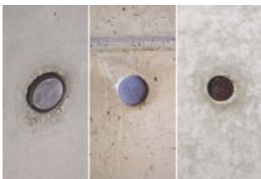
写真9 鉛で埋めた型枠コーン跡 / パウムシューレンヴェーク・クレマトリウム(ベルリン), レディ・オブ・エンジェルス大聖堂(ロスアンゼルス), ソーク生物学研究所(ラ・ホヤ)など, 各所で見かける汎用的なディテール。
