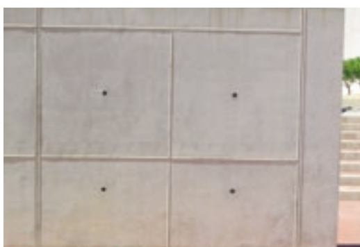
写真10 三角形の出目地 / ソーク生物学研究所(ルイス・カーン, ラ・ホヤ)の三角形の出目地や鉛で埋めたコーン穴は, キンベル美術館と同じディテール。
