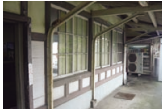
写真7 古レール建築 / 伊予鉄道・高浜駅は、木造とのハイブリッド構造。駅前に高浜港があるが、下車した客の多くは松山観光港行き連絡バスに乗る。
