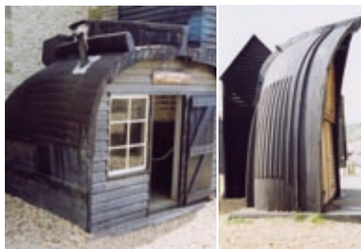
写真15 漁船を転用した建物 / ヘースティングス（イギリス）の漁師の小屋には、木造の漁船の船体を切断して立てたものや、伏せたものが見られる。
