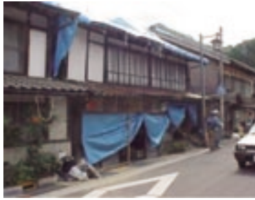
写真2 鳥取県西部地震の被災家屋
