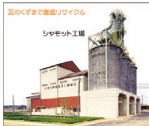
粘土瓦微粉碎工場（シャモット工場）
