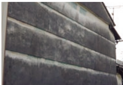
写真12 壁面の水切り・2 / 高知県の民家では土佐漆喰も有名だが, 漆喰に段差を付けた壁面のディテールも多く見られる(伊野)。
