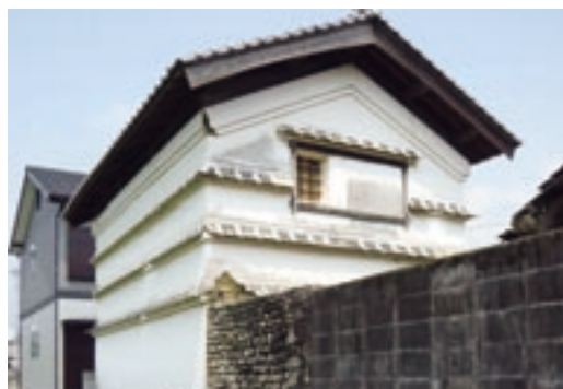
写真11 壁面の水切り・1 / 壁面に瓦1~2枚ぶんの底を何段か設けるディテールは, 高知県でよく見られる(奈半利)。
