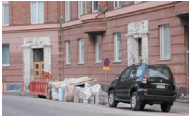
写真8 厚塗りモルタルで改修した直後
