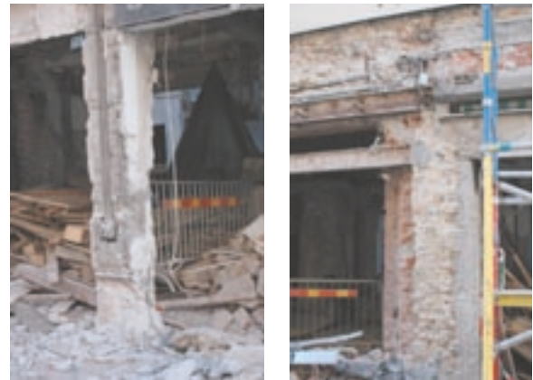
写真9 レンガ造建物の用途変更リニューアル工事
