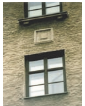
写真3 薄付けモルタルによる外装改修工事
