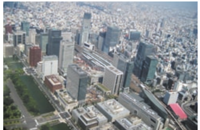
写真1 空から見た東京駅周辺のビル街と密集した市街地
