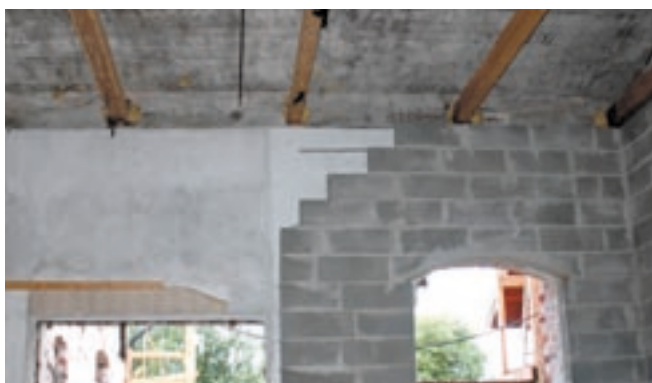
写真4 用途変更が決定しているれんが造建物の改修
