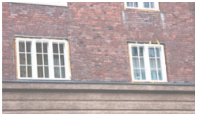
写真2 窓周りの断熱改修工事
