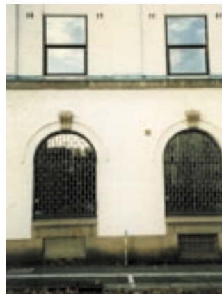
写真3 薄付けモルタルによる外装改修工事
