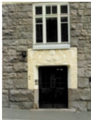
写真6 石造建築における開口周り改修
