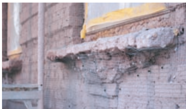
写真7 最近の厚塗り改修工事状況
