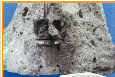
防水カップに付着した 打設コンクリート
