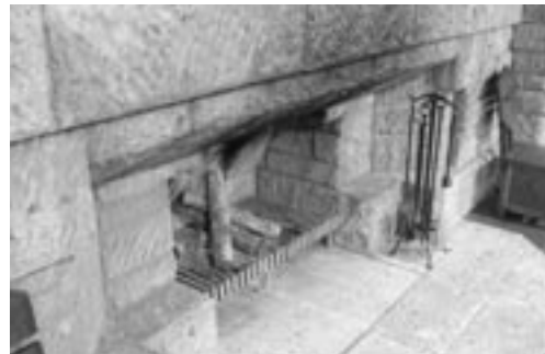
写真2 ホールに設けられた暖炉
