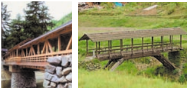
写真2 屋根付きの木造橋 (左:平成14年完成の御幸橋,右:昭和19年に架けられ現存する田丸橋)
