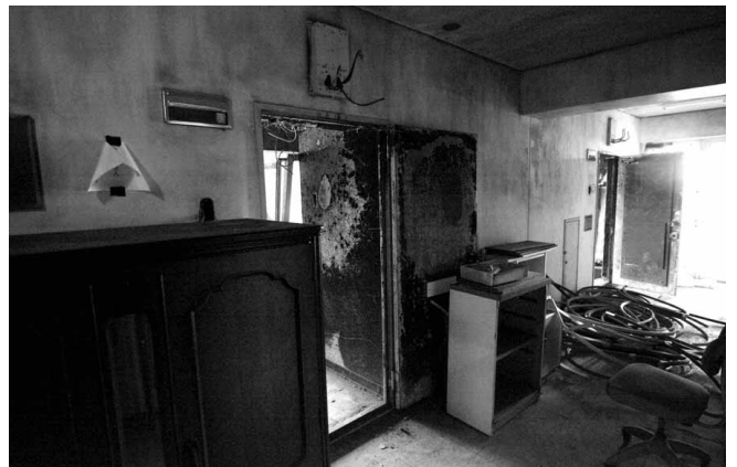
7階の火事を起こした2室。ドアは開いていて、真っ黒に焼け焦げた室内が見える。廊下は薄暗く、粗大ゴミが散乱
