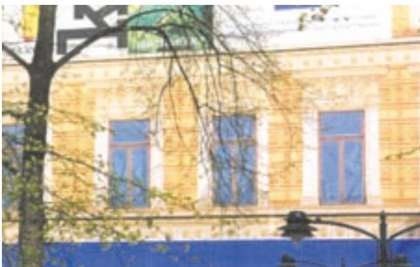
写真6 改修前の外観を印刷した養生シート
