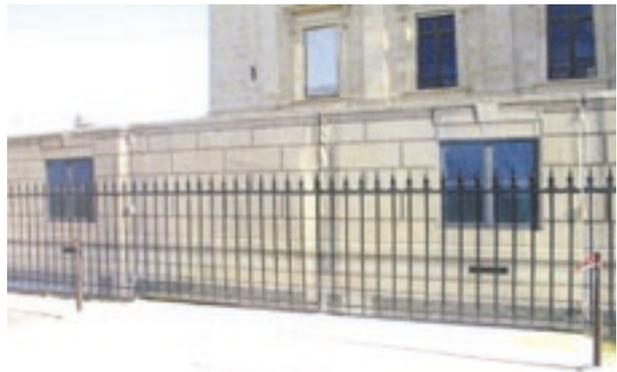
写真7 石積み調の図柄を描いたシートの例
