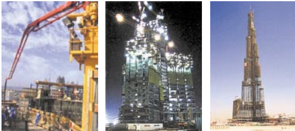
写真1 ドバイのBurj Dubai (Burj Khalifa) 建設工事におけるコンクリート圧送状況 3)
