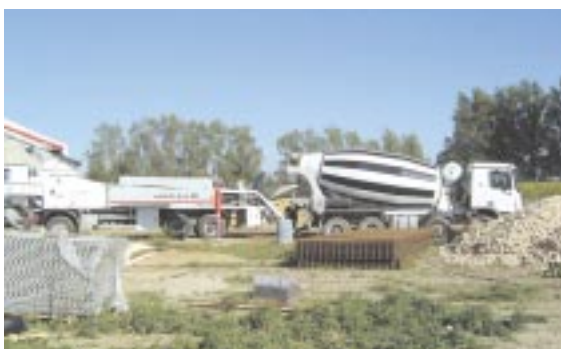
写真5 コンクリートポンプ車(BSF52-5シリーズ)とトラックミキサの荷卸し状況
