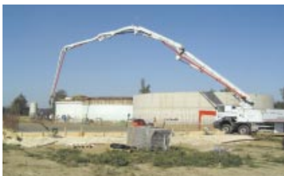
写真5 コンクリートポンプ車(BSF52-5シリーズ)とトラックミキサの荷卸し状況
