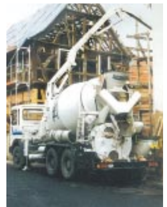
写真4 PUMIによる打設状況
