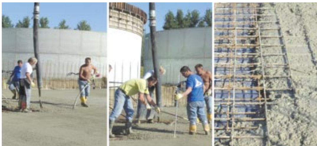
写真6 現場におけるコンクリート打設状況
