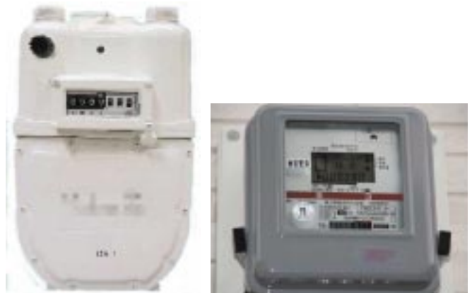
写真1 ガスメーター及び積算電力計
