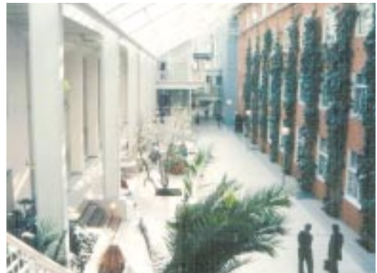
写真4 ノルウェー科学技術大学の既存校舎2棟の間にガラス屋根が架けられただけのアトリウム
