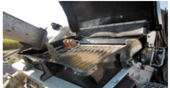
写真10 ポンプへの荷卸し状況
