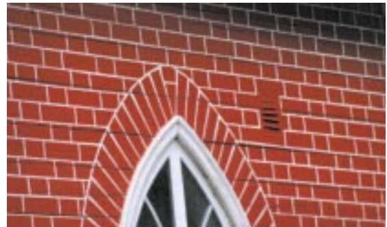
写真1 ログハウスの板張り外壁にペイントでれんが調に描いた例
