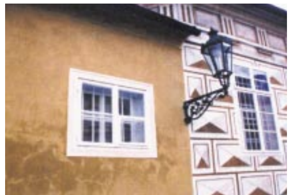
写真3 立体感を持たせた石調仕上げ塗装の例
