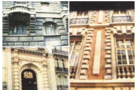
写真6 石調仕上げさまざまなパターン
