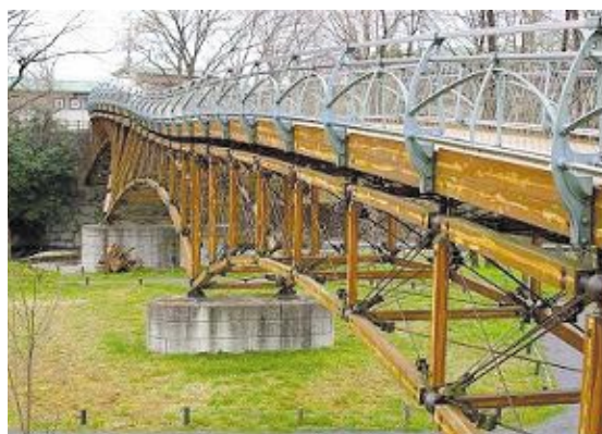
写真1 熊本産のスギ製材を使用した3連式木製トラス橋
