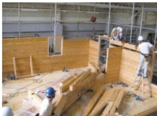
写真2 丸太組構法住宅の建て方
