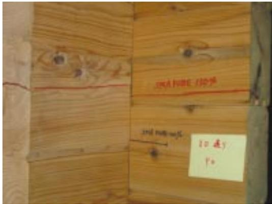
写真8 ログ材の水平ずれ(割れ)発生状況
