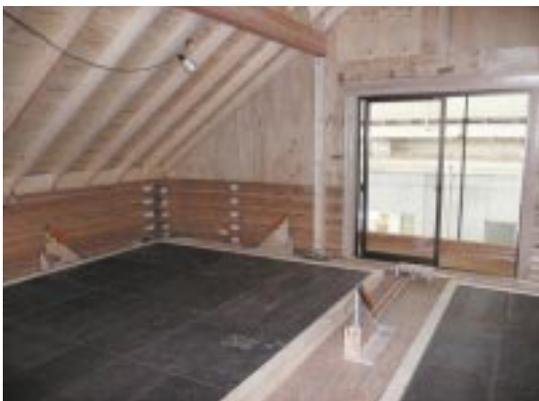
写真6 2階床上の鋼板搭載状況
