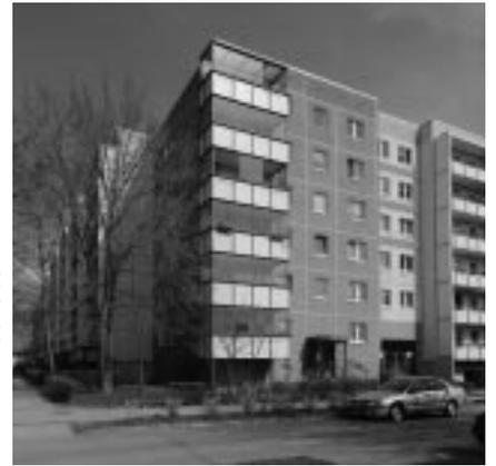
マルツァーン団地の一角。従前の無機質なパネル住宅は空き家が増えていた。上階を除去・減築し、バルコニーを付加、断熱改修、ファサードに色彩を施し変化を付けるなどし、機能や親しみやすさを向上させた。(撮影：筆者)
