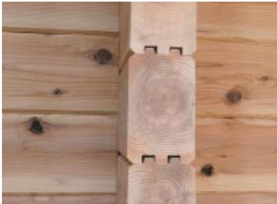
写真5 ログ材の断面
