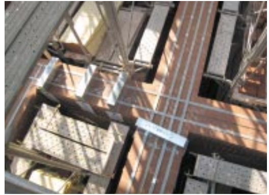
写真10 壁体内の帯鉄
