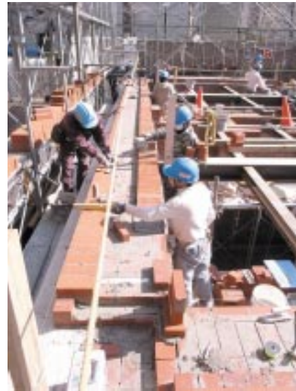
写真11 煉瓦積み工事の様子
