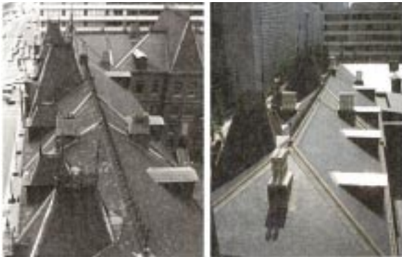
図3 屋根外観 左：旧建物（三菱地所所蔵） 右：復元建物（三菱地所設計提供）
