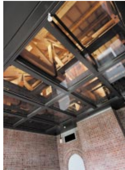
写真16 耐火ガラス天井ごしに見上げる小屋組
