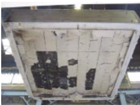
図13 試験後の下面 不燃材被覆仕様
