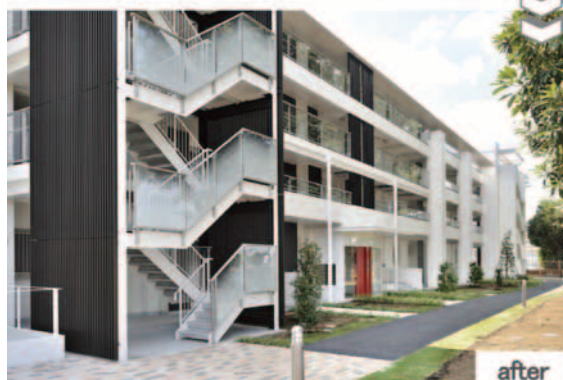
写真1 A棟北東側から見る
