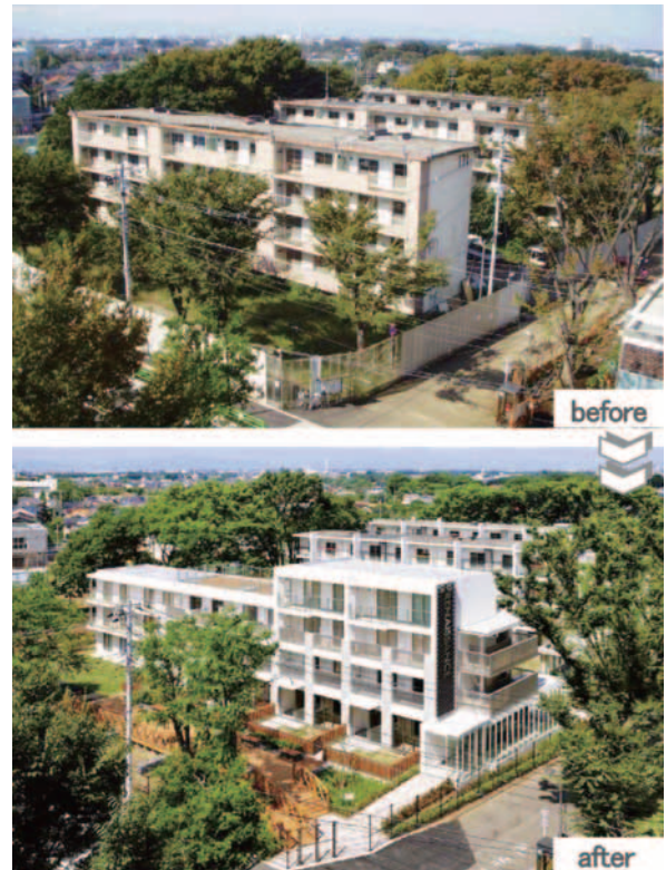
写真3 C棟南側より見る
