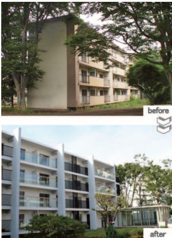
写真2 B棟南東側から見る
