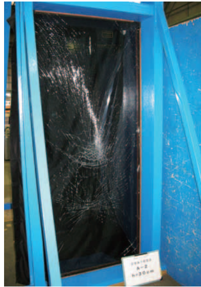
写真3 破壊状況 試験項目：ショットバッグ 試験片番号：A-2 ・板ガラスの破壊
