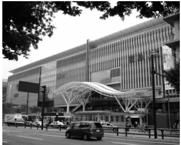
写真1 JR博多シティ外観
