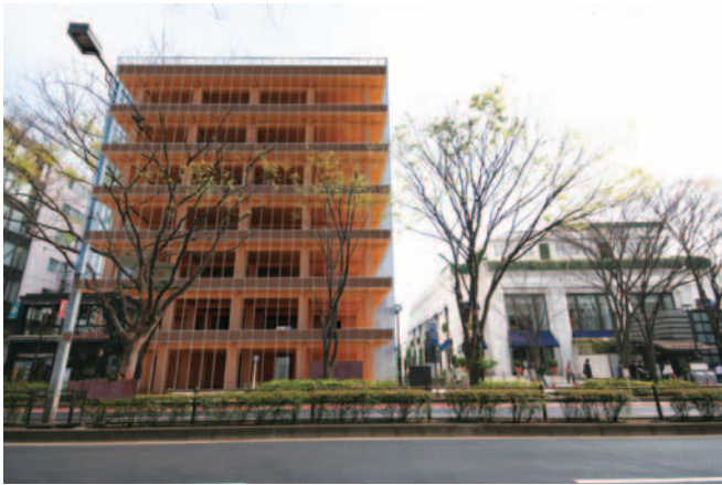
写真8 木造オフィスビル
