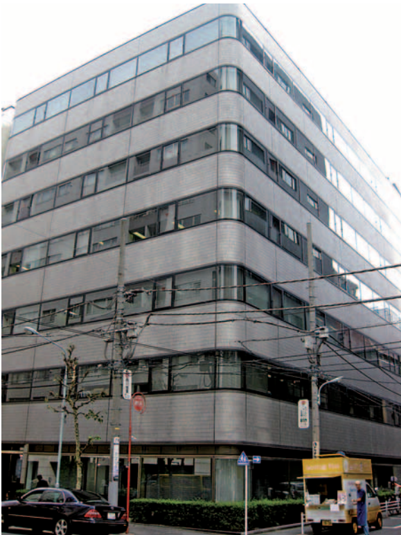
写真6 日本橋コアビル 外観
