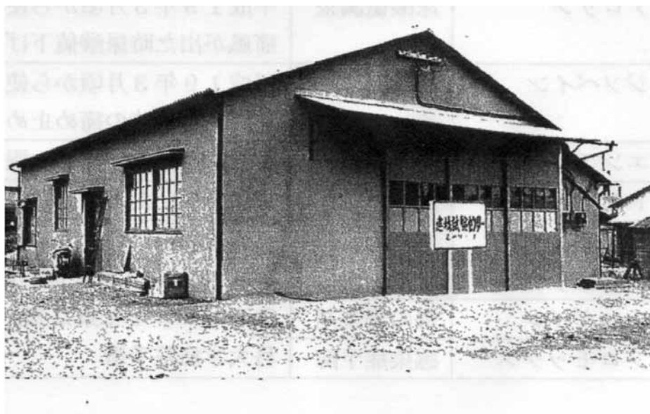
1963年度 完成の小菅試験所 （財）建材試験センター10年の歩みより
