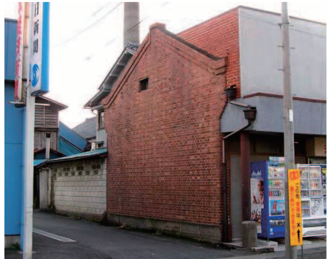
写真1 街区境の防火壁
