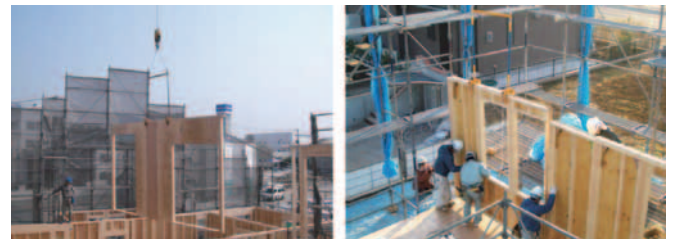
写真2 壁パネルによる建方工事の例
