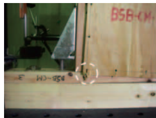
写真12 面材の縁切れ
