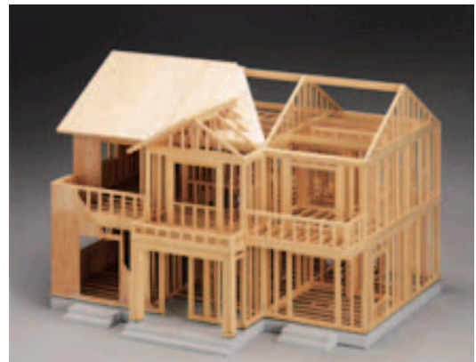
写真1 枠組壁工法住宅の構造模型
