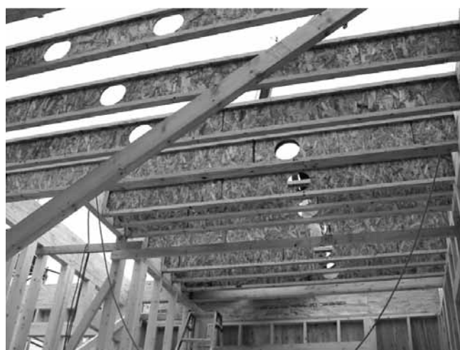
写真6 I形ジョイストの施工例
