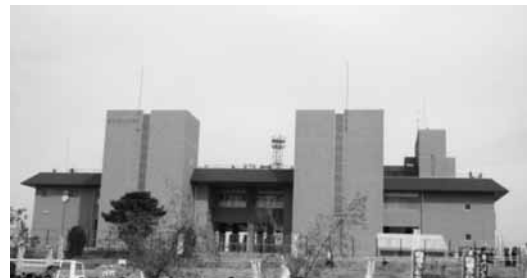
写真1 庄和排水機場「龍Q館」
