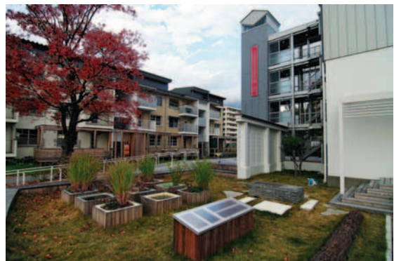
UR都市機構の向ヶ丘第一団地ストック再生実証実験。民間からは戸田建設グループ、大阪ガス等が改修の実証実験に参加。住棟にEV棟を付設し、外観の刷新を図った
