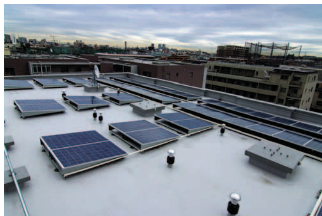
リノベーションに当たって太陽光発電パネル70枚を屋上に設置した。共用部分で年間約6トンのCO 2 排出量が削減できるという
