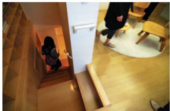
床スラブに孔を穿ち階段を設け、上下階でのメゾネットを実現した
