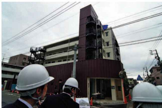
リノア元住吉。もともと1989年に竣工した大手企業の社宅だった。RC造5階建て24戸。2011年1月改修のうえ分譲
