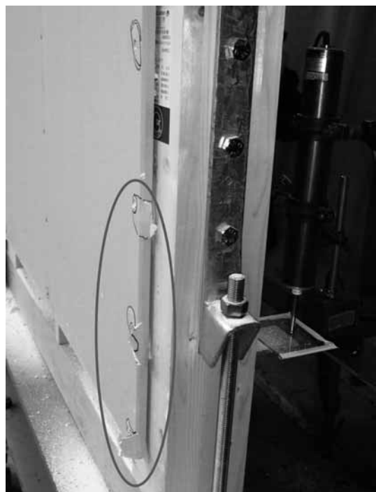
写真2 面材側面の支圧状況
