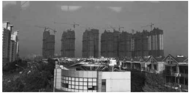
写真19 建設中の高層住宅群
