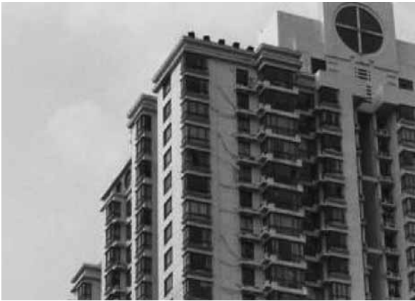
写真18 空調機の配管が多数伸びている
