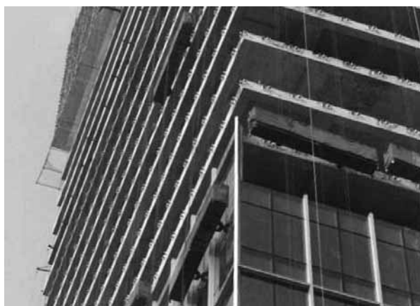
写真14 カーテンウォールの施工箇所
