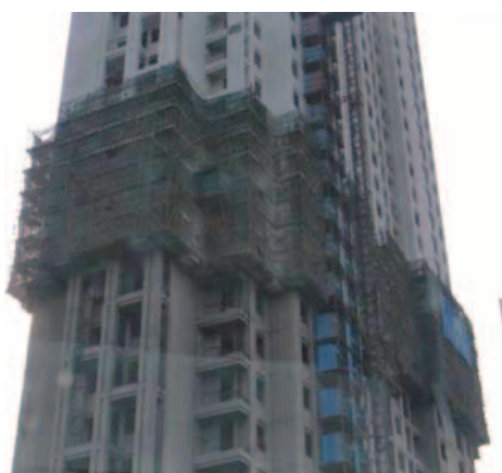
写真7 補修工事中のビル
