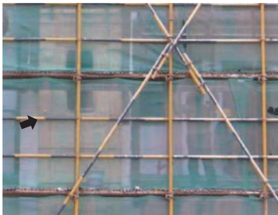
写真5 外断熱の施工（開口部周り）
