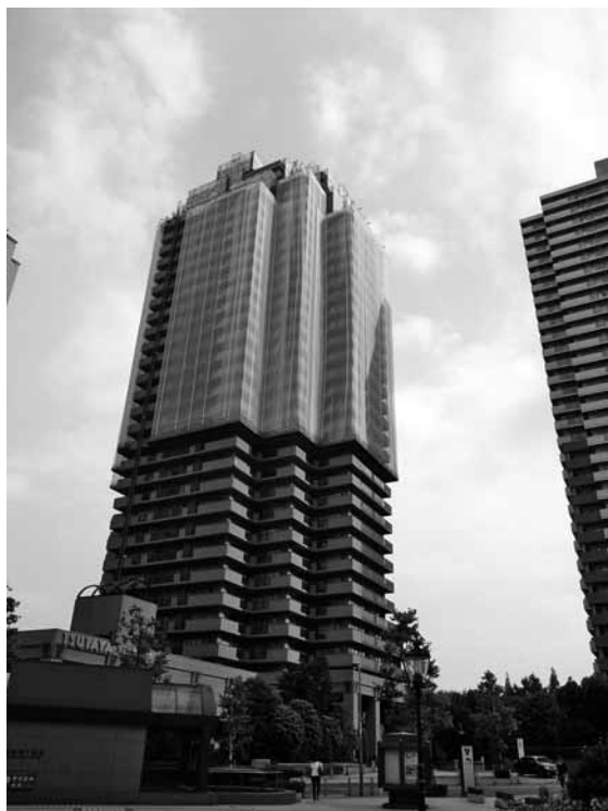
東京・恵比寿の築16年の超高層マンション。一昨年、ゴンドラによる外壁の修繕を行った。(撮影・筆者)
