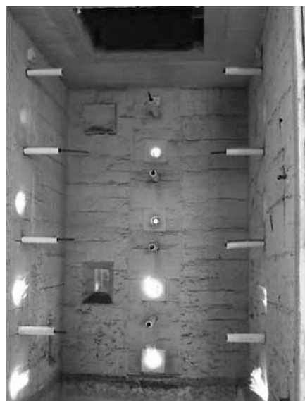
写真3 ガス燃焼バーナーの燃焼状況
