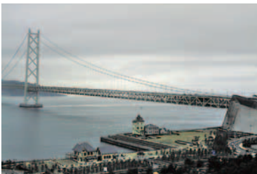
写真1 明石海峡大橋(右端に巨大なアンカレイジ)
